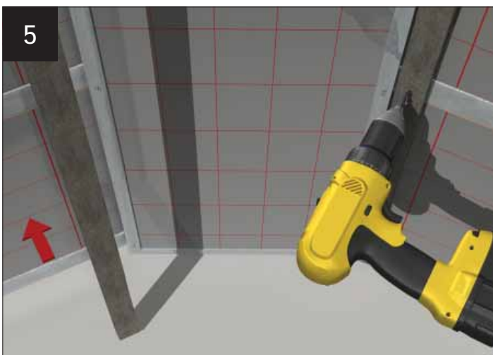
Attacher les liteaux de bois en ligne sur chaque entrait à l'aide de vis pour placo
