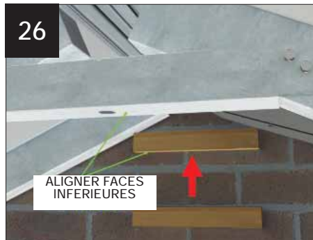
26 Poser une longueur de linteau dur le mur d'appui en s'assurant que le dessous du linteau est aligné avec le dessous du faux-entrait (LVTS001 / LVTS002) Cela procurera un point d'appui pour le panneau central sous faitière.
