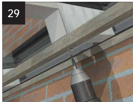
29 Fixer des linteaux supplémentaires au niveau des vitrages situés le long du mur d'appui
