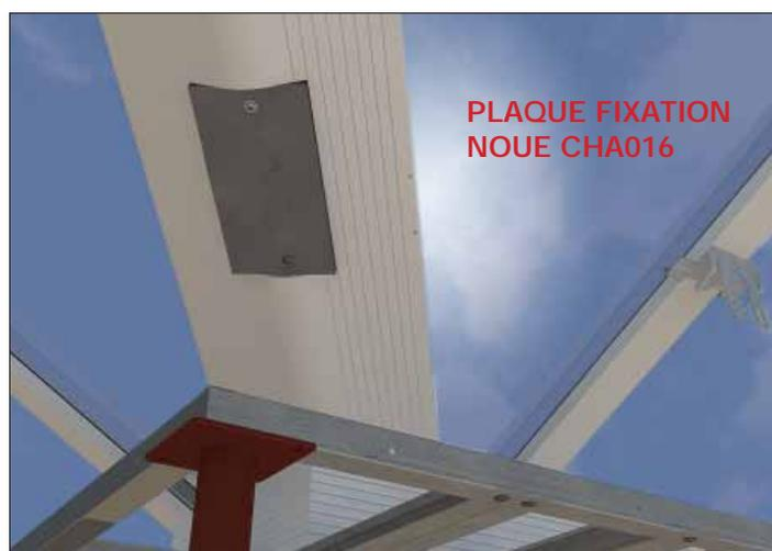
Marquer et découper l'habillage intérieur de la noue. Attacher la plaque de fixation de la noue en suivant les étapes 1 à 5 ci-après.
