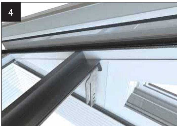
Présenter le support intercalaire du cache d'armature. L'aile du support intercalaire doit être découpée comme montré ci-contre - uniquement du côté de la façade (Gable).
