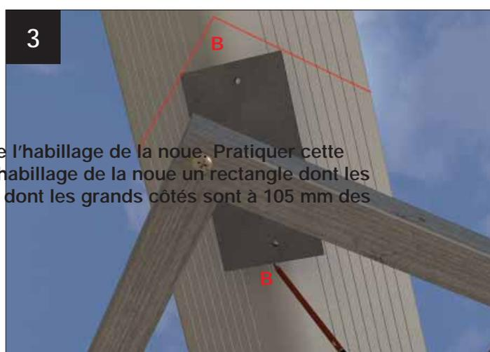
3 Placer la plaque de support de noue temporairement au centre de la noue avec les angles supérieurs touchant les lignes tracées à la case 2. Tracer sur l'habillage intérieur de la noue deux lignes "B" suivant les deux petits côtés de la plaque. Retirer la plaque de fixation de la noue.
