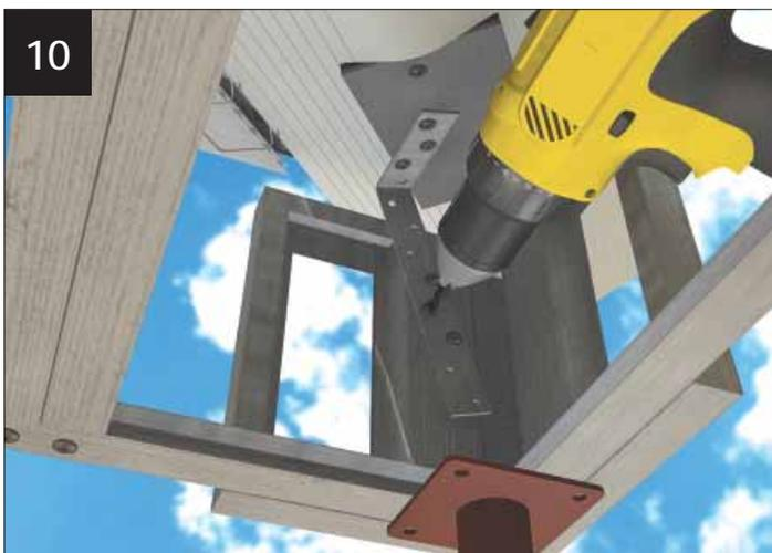
A L'AIDE DE VIS M4 x 13 mm AUTO PERFORANTES, FIXER L'EQUERRE CHA018 à l'angle d'armature et à la plaque de fixation de la noue. Il peut être nécessaire de plier le CHA008.
