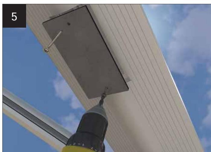
5 Poser la plaque de fixation de la noue comme montré ci-dessus. Fixer au profil central de la noue (connecteur) à l'aide de deux CHA017 Pointes 4.8 x 70 mm auto-perforantes.
