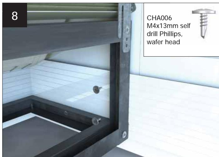
Fixer l'armature verticale dans le bandeau de finition à l'aide de deux vis Phillips M4 x 13 mm auto-perforantes, à tête mince (fournies).
