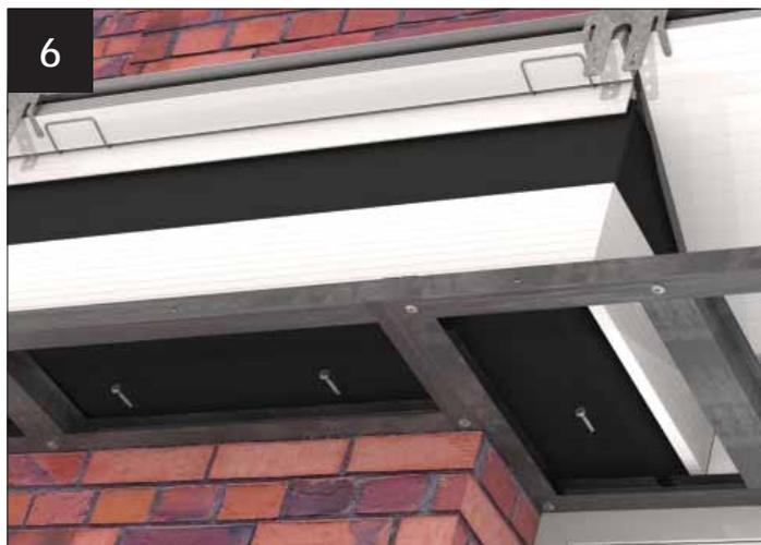
Fixer l'armature horizontale comme dans une installation standard à l'aide de vis CHA008 (livrées en sac de 25 unités).
