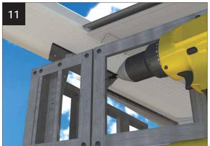
Poser les armatures verticales. Fixer ces armatures à l'angle d'armature ainsi qu'aux armatures horizontales.
