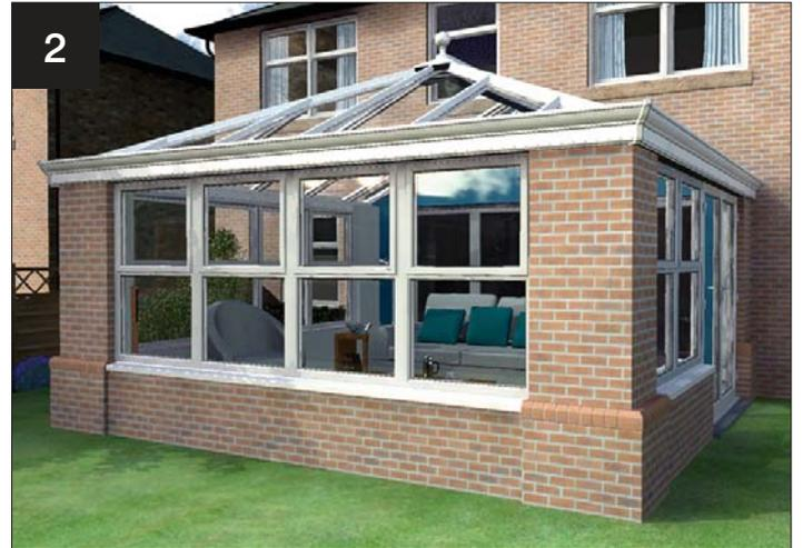
2 L'addition d'une corniche décorative à l'extérieur, et (éventuellement) de montants de maçonnerie dans les angles modifie l'aspect de l'ensemble.
